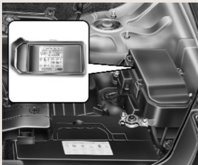
Panel sa osiguračima u odeljku motora
